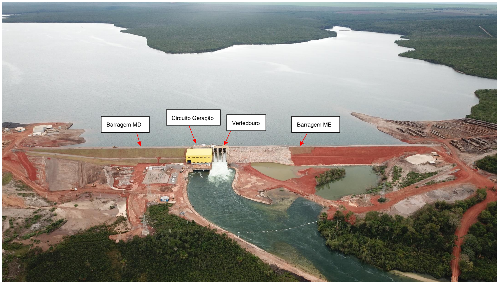
Figura 1 – Foto das estruturas civis– PCH Jesuíta
