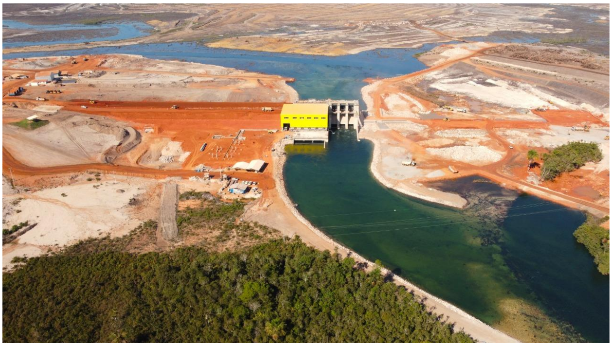
Figura 33 – Construção da PCH Jesuíta
