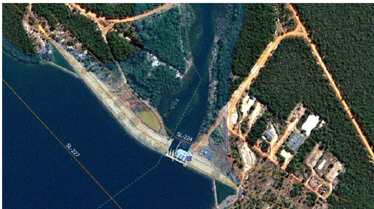
Figura 38 – Localização Barragem/Casa de Força PCH Segredo - SL-225/224
