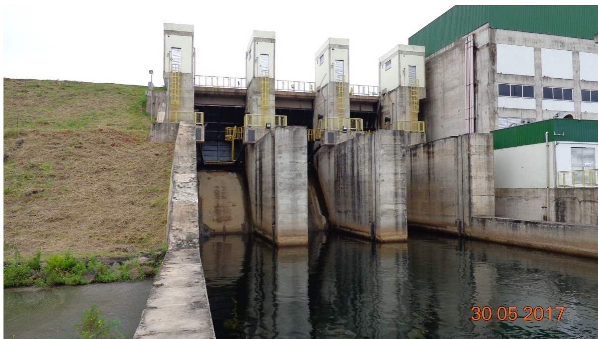
Figura 8 – Vista Geral do Vertedouro
