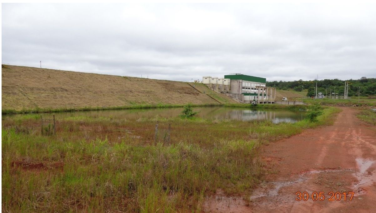
Figura 7 – Vista Geral da Barragem
