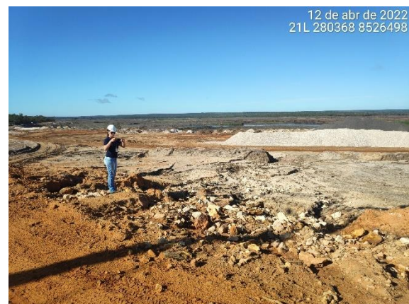
Foto 18 - Monitoramento dos processos erosivos.
