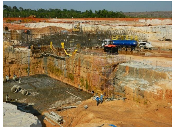
Foto 4 - Arenitos no local onde foi escavado para instalar a casa de força.
