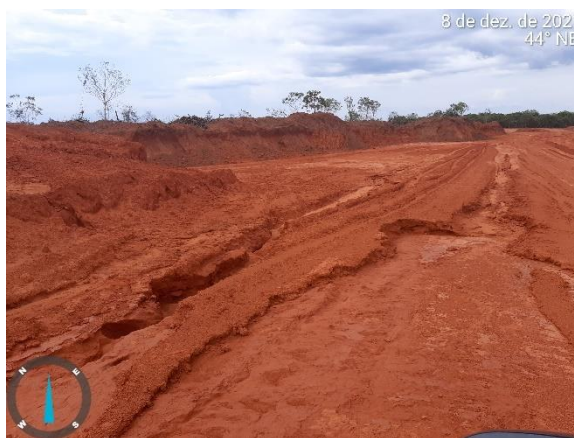
Foto 21 - Monitoramento dos processos erosivos em vias de acesso.
