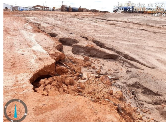
Foto 20 - Monitoramento dos processos erosivos.
